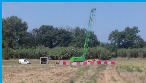
Le forage de La Boissière a été réalisé entre le printemps 2021 et l'hiver 2022. Il exploite une ressource karstique et atteint 300 m de profondeur. Le nouveau forage étant implanté à quelques mètres du forage actuel, les travaux ont dû être reportés en période de faible consommation afin de ne pas nuire à la qualité de l'eau produite.
